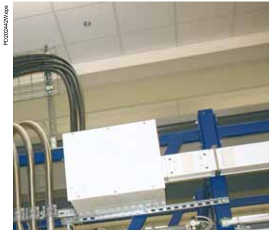
Canalis KS and sprinkler.
