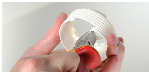
Isoleringsring i nedsænket loft.
